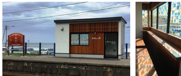
桑川駅下りホーム 新設待合室
