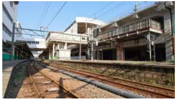
旧 1 番線・2 番線の線路の一部
